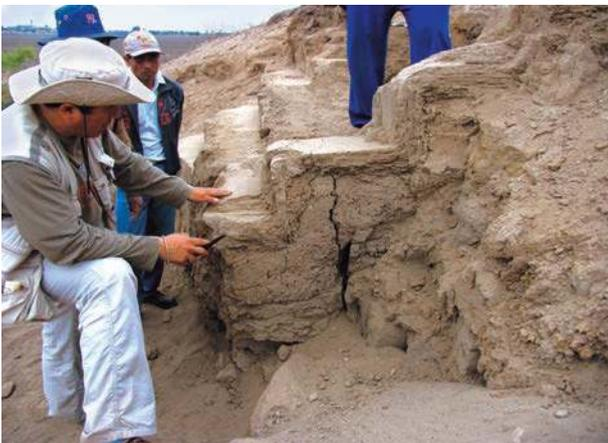
Fig. 303 Capas de enlucido y refacciones de la escalinata.
