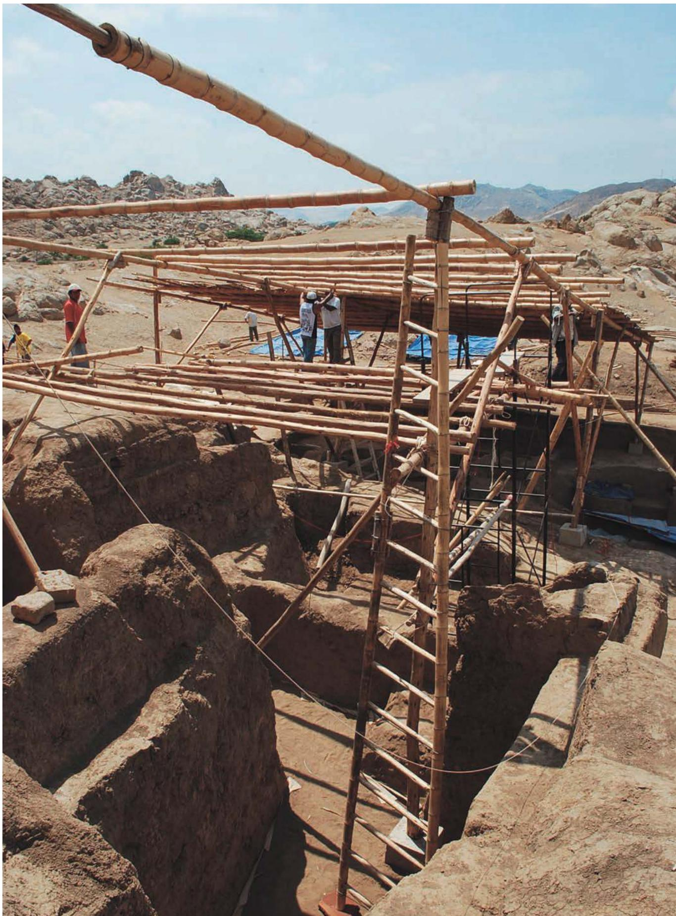
Fig. 01 Proceso de instalación de Cobertura provisional Sector Sur Huaca Ventarrón.
