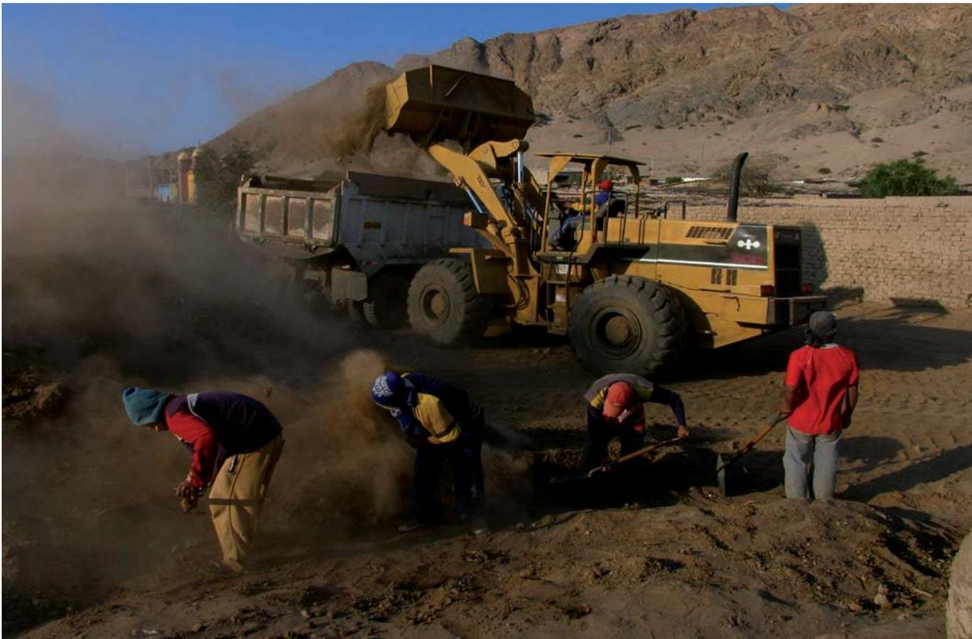
Fig. 11 Remoción de basura usando maquinaria pesada, se apilaron previamente desechos y escombros que llenaron 150 viajes de camión.
